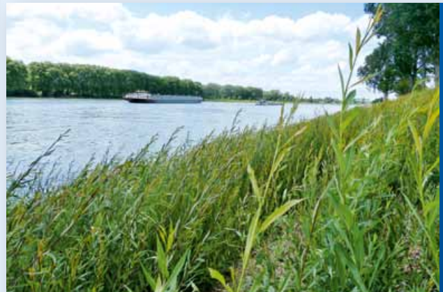
Technisch-biologische Ufersicherung am Rhein
