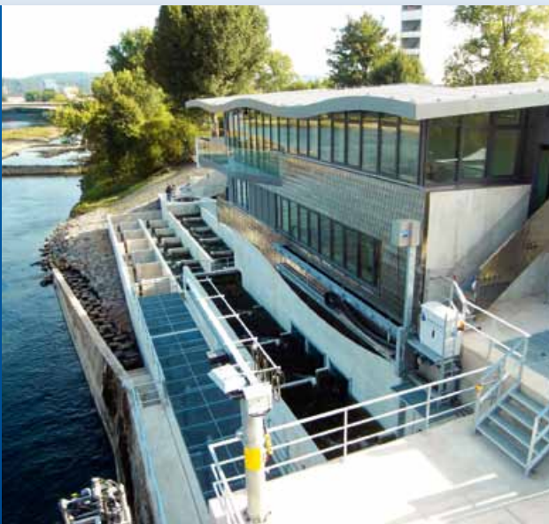
Fischwechselanlage Koblenz mit Informationszentrum
