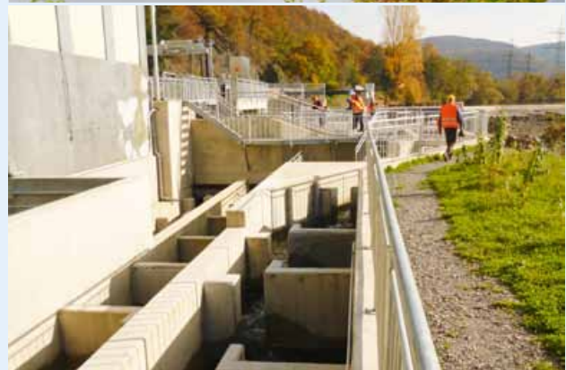
Wasserkraftanlage der RWE Innogy GmbH in Windeck-Stromberg (Sieg) vor (Foto oben) und während des Baus der Fischschutz- und Abstiegseinrichtungen (unten)
