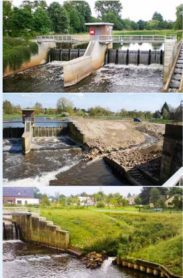
Dinkelwehr in Neuenhaus vor, während und nach dem Bau des Umgehungsgerinnes
