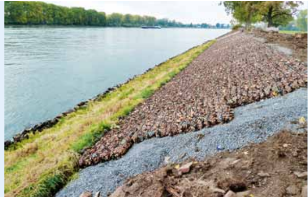
Versuchsfeld in der Bauphase
