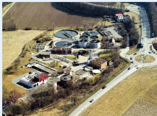
Kläranlage Öhringen vor und nach dem Ausbau
