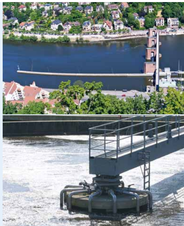
Stauwehr am Neckar und Kläranlage
